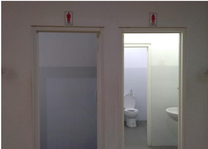
Foto 5.16 Sarana dan Prasarana Toilet
